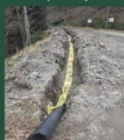
Linia de medie tensiune îngropată în drum.
